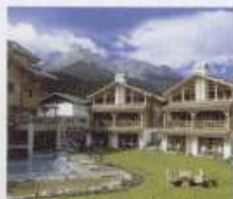
Außenansicht der Chalets in der „Post Alpina“
